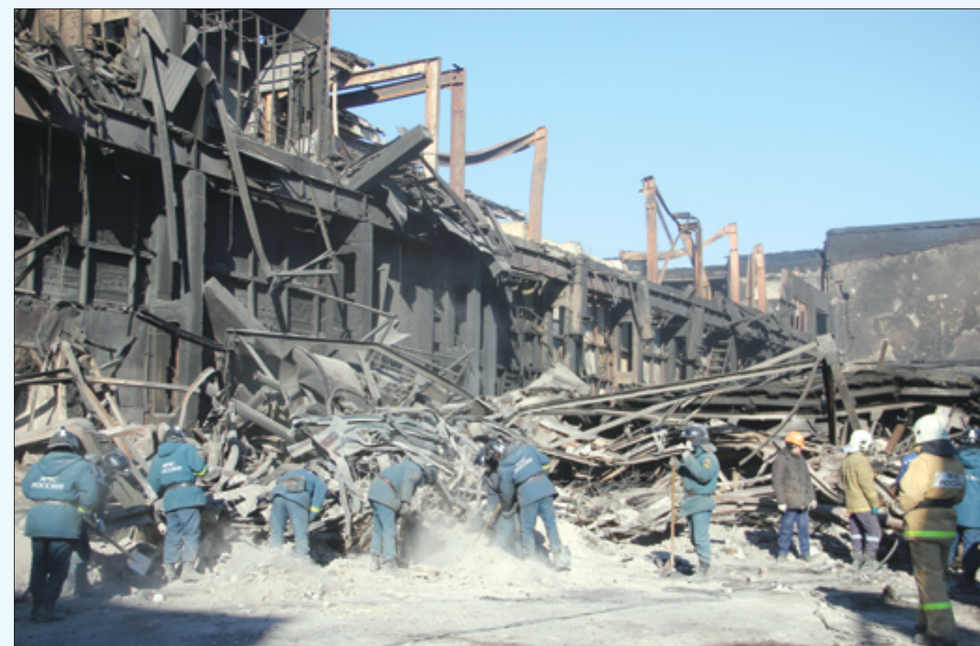
Чтобы ликвидировать завалы, приходилось резать металлические конструкции
